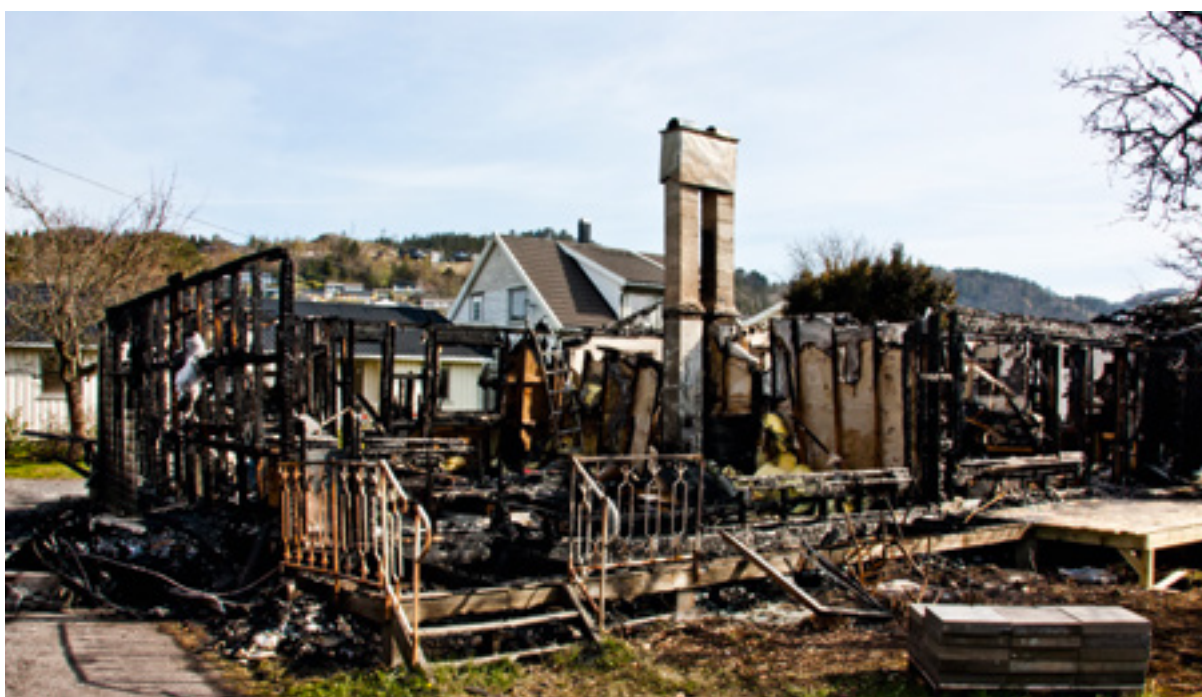
Et rekkehus i Lyngdal med kommunale leiligheter brant ned til grunnen. Bygningen manglet tilfredsstillende brannskiller.
