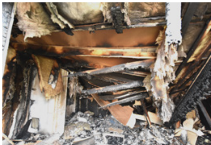
Bildet viser kollaps av horisontalt brannskille mellom første og andre etasje.
