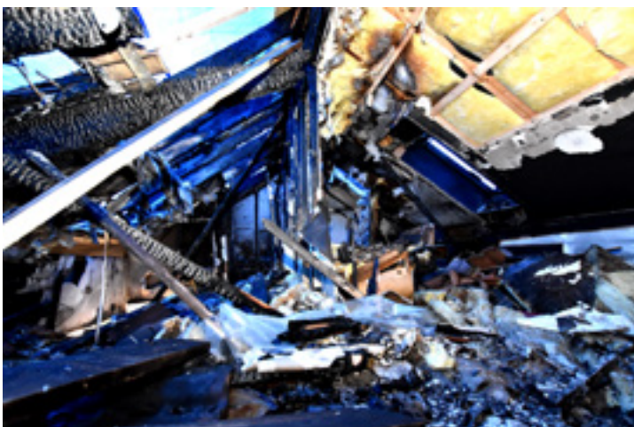
Yttertaket fikk store brannskader. Brannvesenet måtte åpne konstruksjonen for å få slokket brannen.
