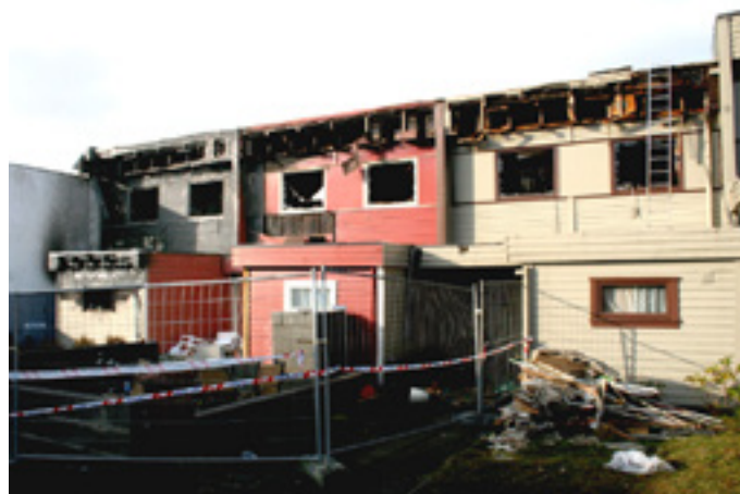
Brann i rekkehus i Sandnes i 2008. Brannen spredte seg blant annet som følge av hulrom i konstruksjonene i taket.
